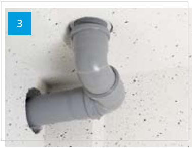
Odvodňovanie strechy sa spojí do jedného potrubia a voda sa odvádza potrubím vnútri alebo vonku na garáži.
